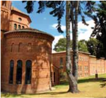
→ ARRIBA: Detalle de la cubierta y cornizamiento de la capilla lateral sur. → DERECHA: Imágen del apside de la capilla donde sobresalen las vidrieras de las ventanas laterales y el trabajo de mampostería, con la presencia de un friso central de traba transversal, enmarcado por dos iladas dentadas. → ABAJO: Imágen del costado trasero de la capilla. Fotografías Carlos Hernández Llamas - IDPC.
