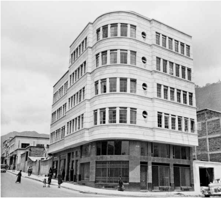
→ Edificio Uribe Ramírez en el año de 1942. Construido por Ospinas & Compañía y Montoya Valenzuela. Colección María Teresa Montoya de Barriga.
