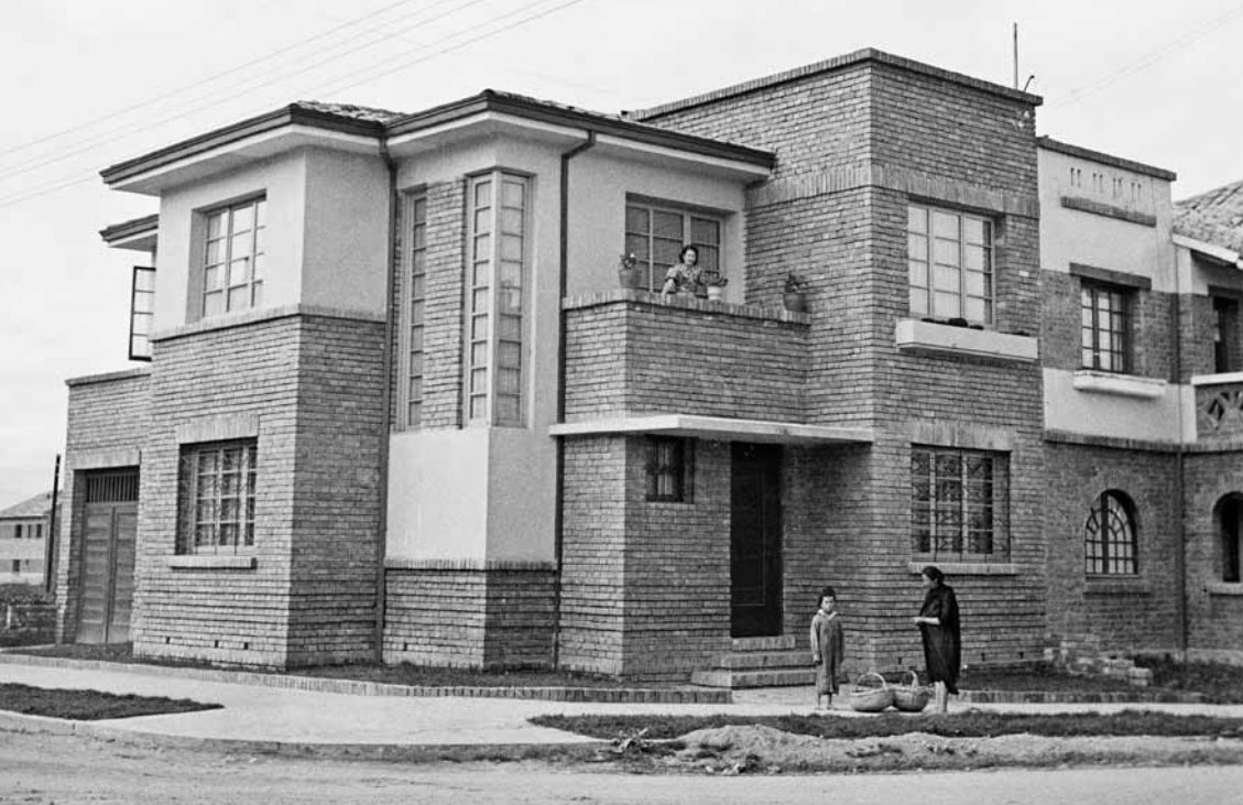
→ Residencia diseñada y construída por José María Montoya Valenzuela en el sector de Chapinero. Se destaca por su composición geométrica de líneas cubistas y por el uso expresivo del ladrillo en alternancia con superficies planas. Ca. 1940. Colección María Teresa Montoya de Barriga.
