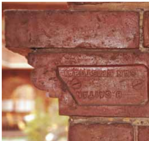
→ Detalle del trabajo de mampostería presente en el edificio de la Universidad Santo Tomás, sobresale la presencia de piezas silueteadas, que configuran a manera de mensulas los capiteles de las columnas.
